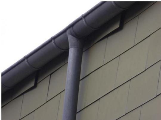
Abbildung 3: Abtstehende Fassadenelemente, Haus 29/31
