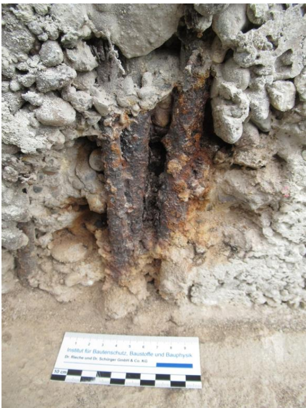
Korrodiertes Bewehrungsstahl an der Außenwand
