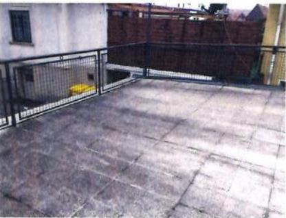
Das Wohngebäude Uhlandstraße 22 erfuhr eine gestalterische und energetische Aufwertung. So wurden insbesondere im Dachbereich umfangreiche Modernisierungen durchgeführt. Das Dach wurde in Verbindung mit den notwendigen Flaschnerarbeiten nicht nur neu gedeckt, sondern auch wärme-gedämmt.
