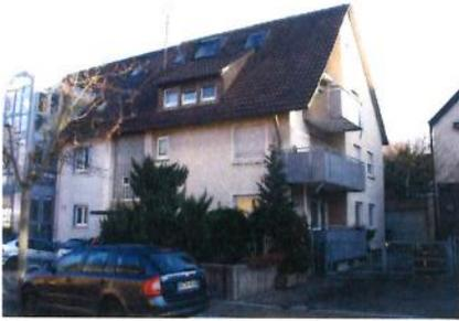
Das Wohngebäude Butterstraße 13/1 wurde insbesondere im Bereich des Daches grundlegend modernisiert. Nach dem Entfernen der alten Ziegel und Lattung wurde das gesamte Dach wärmegeklämmt und anschließend mit neuen Ziegeln gedeckt. Ebenso wurden Flaschnerarbeiten im Dachbereich ausgeführt.
