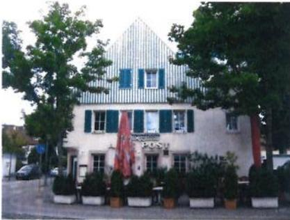
Das gemischt genutzte Gebäude befindet sich im Kreuzungsbereich der Remstalstraße und der Fellbacher Straße. Insbesondere unter gestalterischen Gesichtspunkten erfuhr das Haus eine Aufwertung, so wurden die Fassade instandgesetzt und neu gestrichen, neue Klappläden installiert und der Balkon modernisiert.
