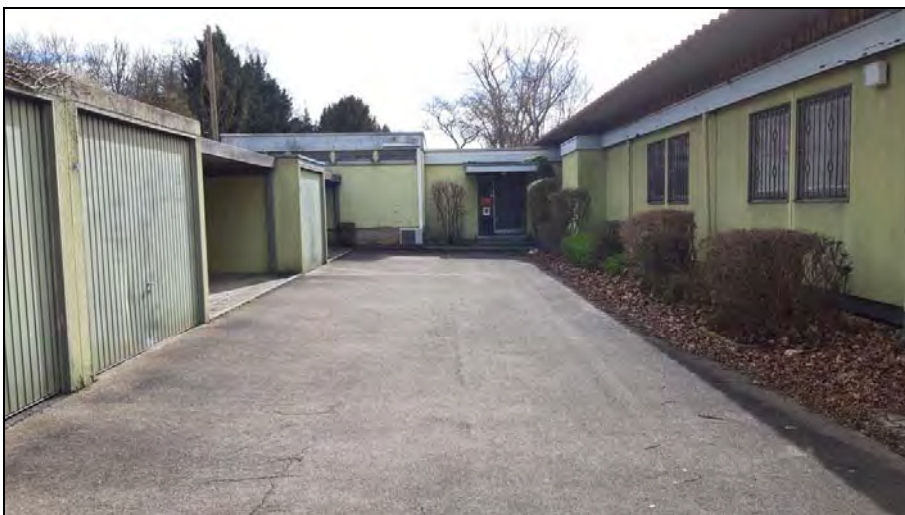
Abb. 8: Leerstehende Gebäude und Garagen
